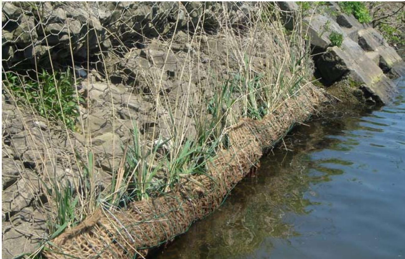
Meuse, Beez. Plantation de Phragmites dans un boudin de géotextile en fibres de coco afin de vérifier si les plants peuvent coloniser la partie immergée du gabion et se rendre progressivement indépendantes.
