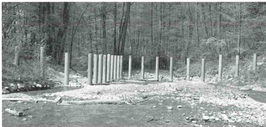
Figure 5 : dans un souci de sécurité, à l'amont de zones sensibles (ponts, zones urbaines, ...), il est possible d'installer des structures artificielles susceptibles de piéger les bois flottants, à partir de pieux placés en travers du cours d'eau (Chäamptonerbach : Allemagne).
