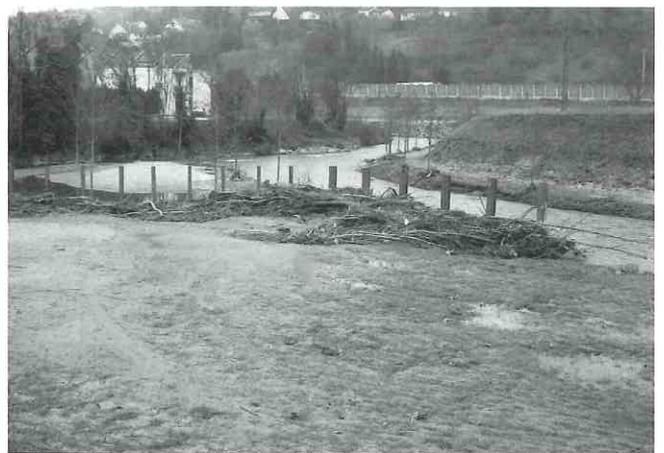
Photo 4 : un piège à corps flottants implanté à l'amont de l'agglomération de Bourgoin-Jallieu dans un lit majeur surbaissé localisé dans une concavité de la Bourbre. La photographie est prise en 2002 à la suite d'une crue importante de la rivière démontrant la capacité du piège à retenir une partie des corps flottants en transit.
